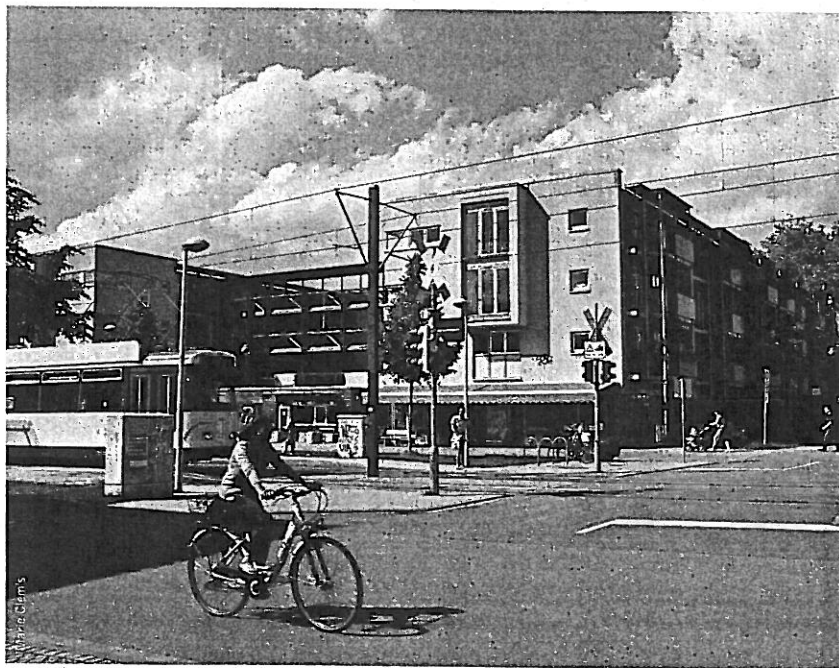
▲ Immeubles coopératifs Geneva dans le quartier Vauban de Francfort (Allemagne)
