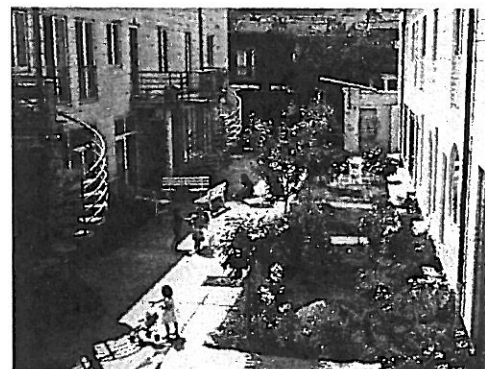
▲ Habitat groupé Couleur d'Orange à Montreuil (Seine-Saint-Denis)
