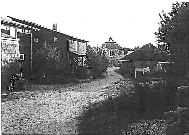
▲ Les premières maisons construites sur le site (groupe 1)
