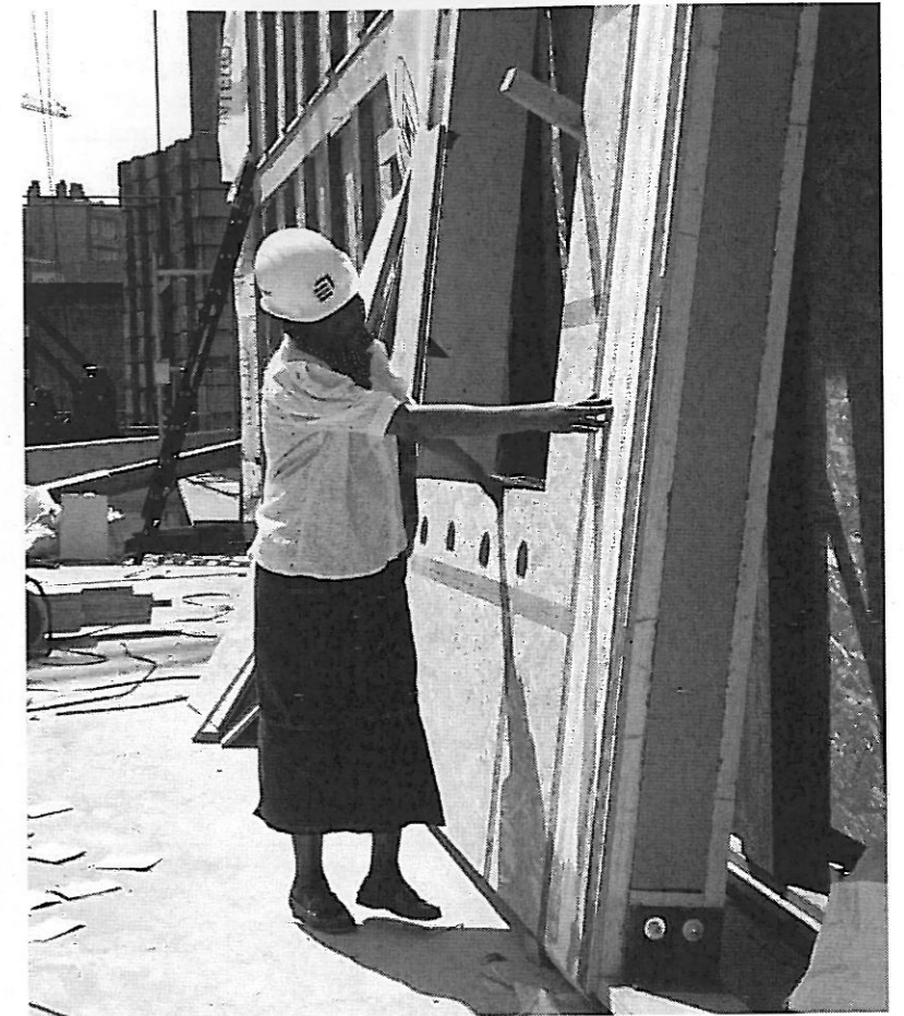
Joséphine, présidente de l'association « l'Espoir » sur le chantier
