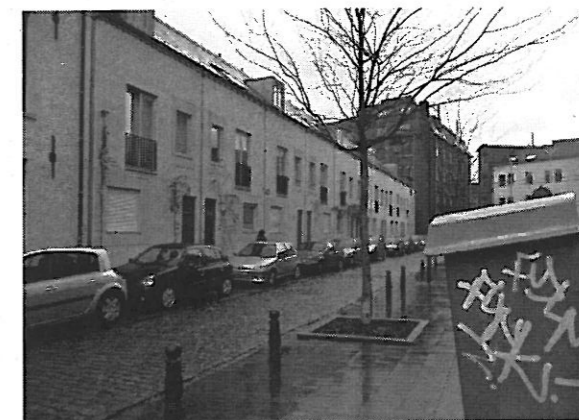
Maisons unifamiliales rue du Rempart des Moines, Bruxelles-ville, construites dans le cadre du deuxième volet des contrats de quartier.
